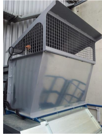
Figure 3 : Auvent anti retour de flammes
